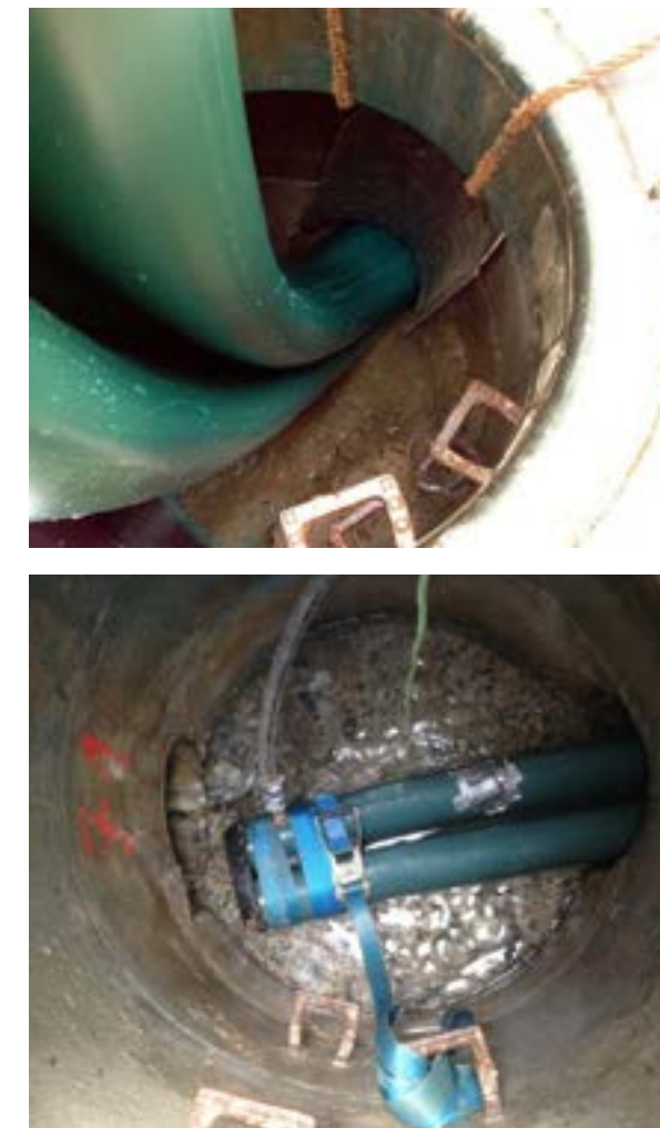
Figura 2.2.5 Come si presenta un condotto Close Fit nel pozzetto di inserimento (in alto) e nel pozzetto di arrivo (in basso) (By Rotech)
