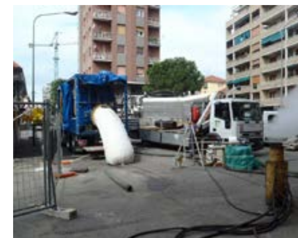
Figura 4.1.4 Inserimento di un liner ad aria (By Idroambiente)
