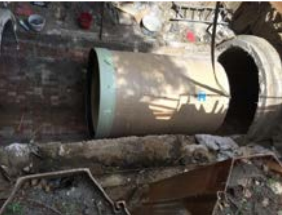
Figura 2.2.8 Inserimento di un tronchetto Discrete Pipe
