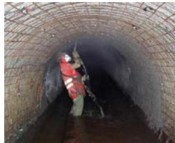
Figura 2.2.15 Esempio di intervento con posa di rete elettrosaldata in collettore di grandi dimensioni
